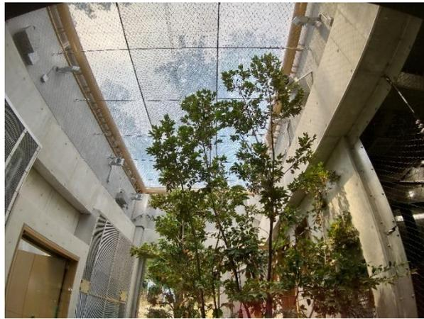
屋内放飼場の屋根。網の向こうが、透明な ETFE フィルムで覆われている。
